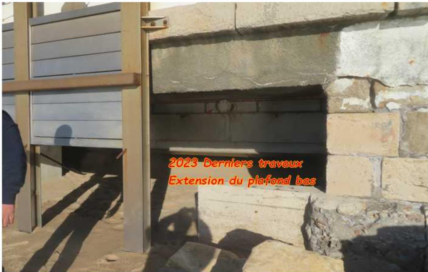
Les multiples travaux effectués dans l'exutoire depuis 2015, chicanes en béton armé, piliers divers, guillotines, extension du plafond bas aggravent fortement la situation.
